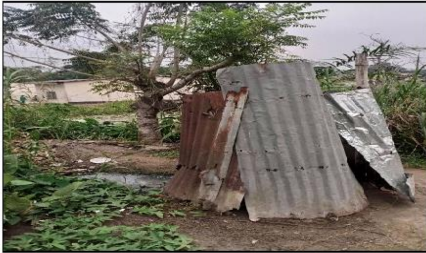
Photo 1 : Eaux de bains d'une fosse perdue
